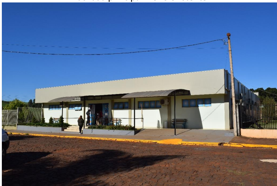
Fachada principal – UBS existente.
