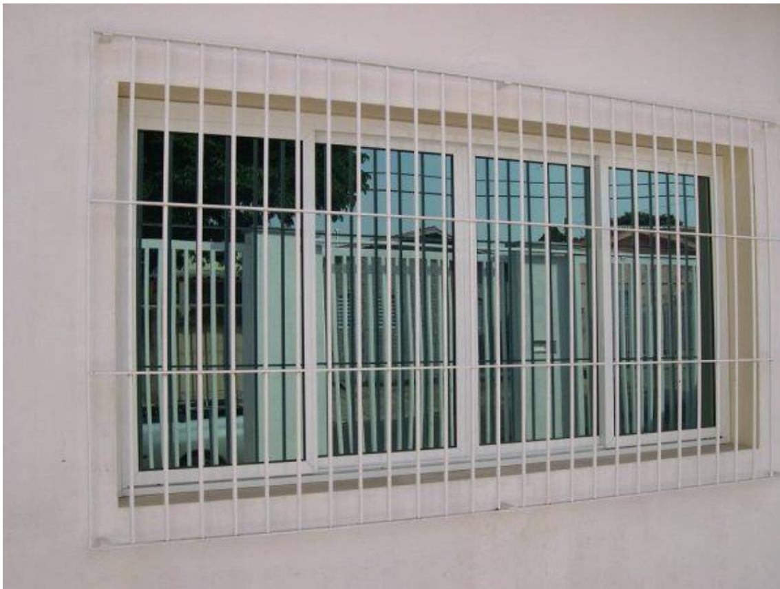
Figura 11: Modelo para execução das grades de proteção.
