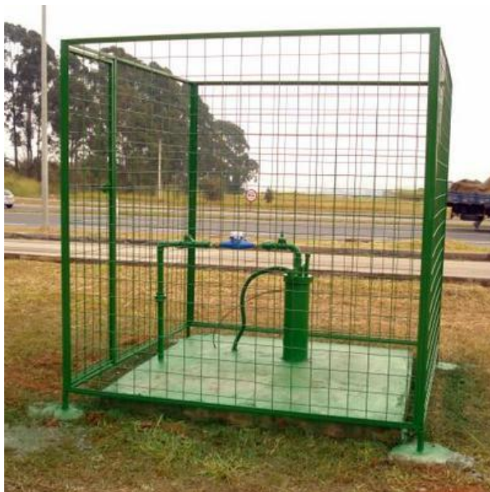
Figura 1: Cercamento nos pontos de captação.
