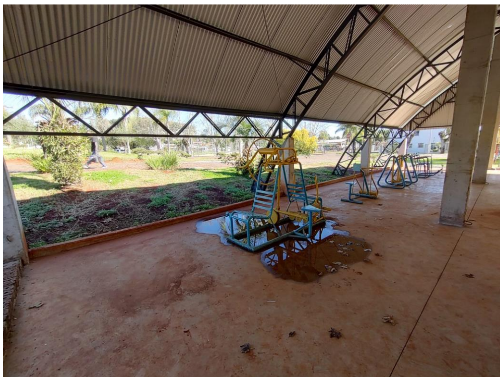
Imagens: Lado direito à ser fechado com alvenaria.
