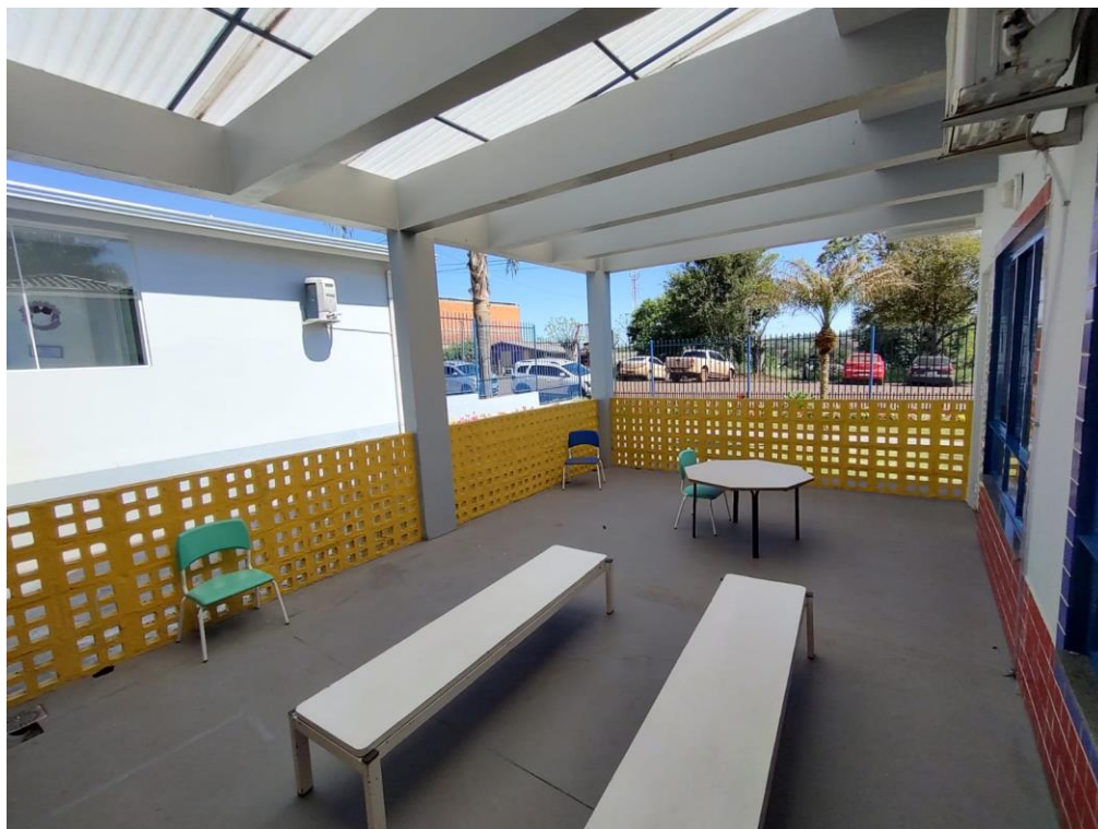
Imagens: Parede à serem fechadas com vidro
