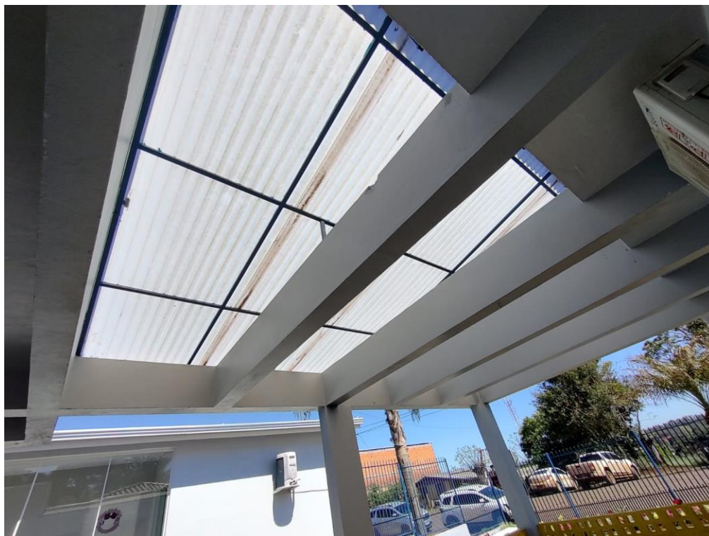
Imagens: Cobertura à ser trocada.
