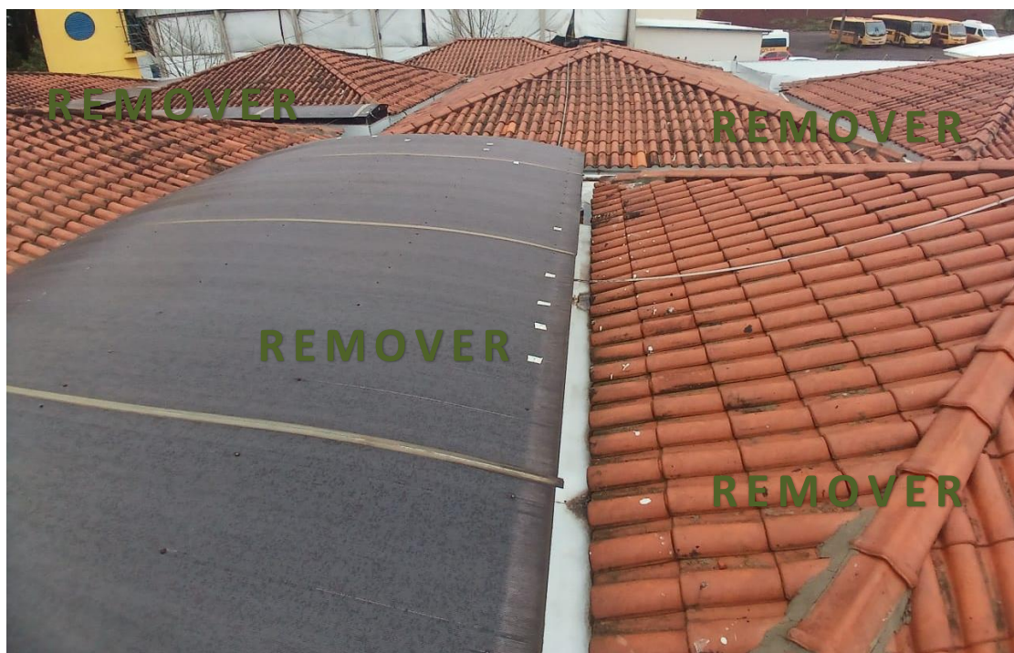
FOTO 02: VISTA SUPERIOR DA COBERTURA A REMOVER
