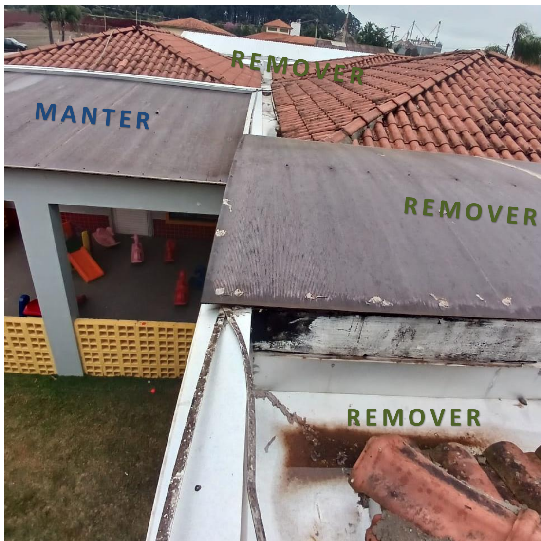
FOTO 03: VISTA SUPERIOR DA COBERTURA A REMOVER
