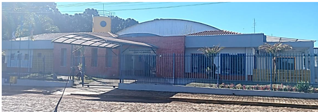
FOT01: FACHADA ATUAL
