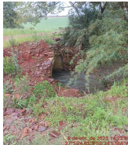
Fotos local 04 (despreendimento de manilhas, processo erosivo)
